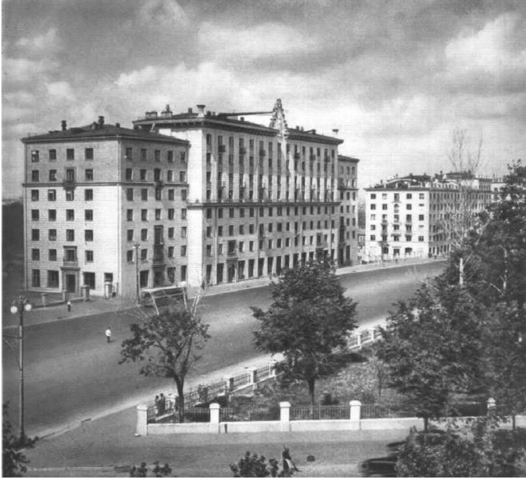
Г.П. Гольц. Жилой дом на Большой Калужской улице. 1940 г.
